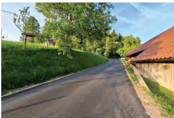
Obnovljen odsek lokalne ceste pri Vinarniku
