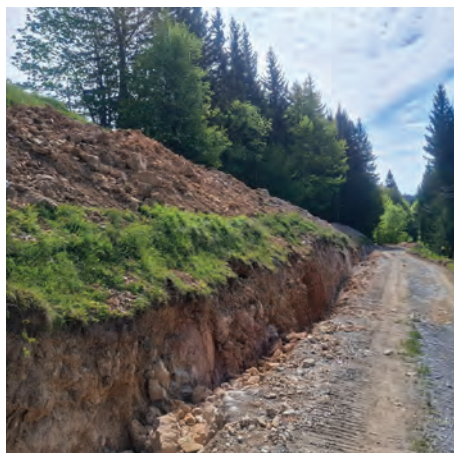
Izkopi trase proti odcepu pri Magu, kjer poteka priprava za polaganje cevi.
