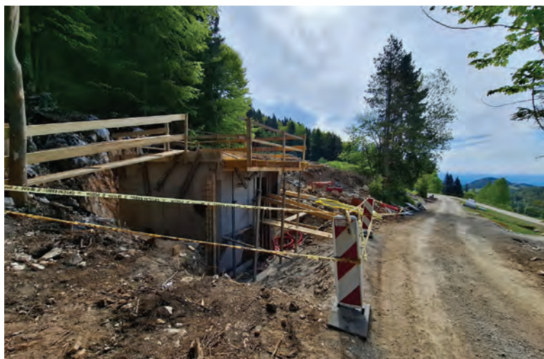
Gradnja vodohrana pri Juriju (Bračič), kjer bo vgrajen pomemben del oskrbne infrastrukture.
