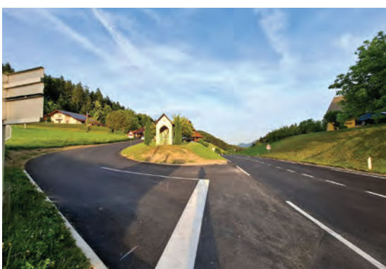
Vrh Prevaljskega klanca in odcep proti Loški Gori
