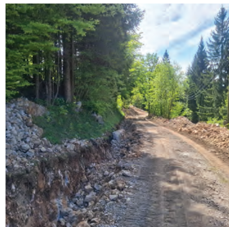
Na celotni trasi so potekali zahtevni izkopi in pikiranja v trdih terenih.
