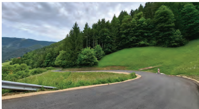
Obnovljen odsek v Breznu
