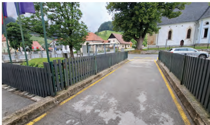
Obnovljena ograja na mostu pred osnovno šolo
