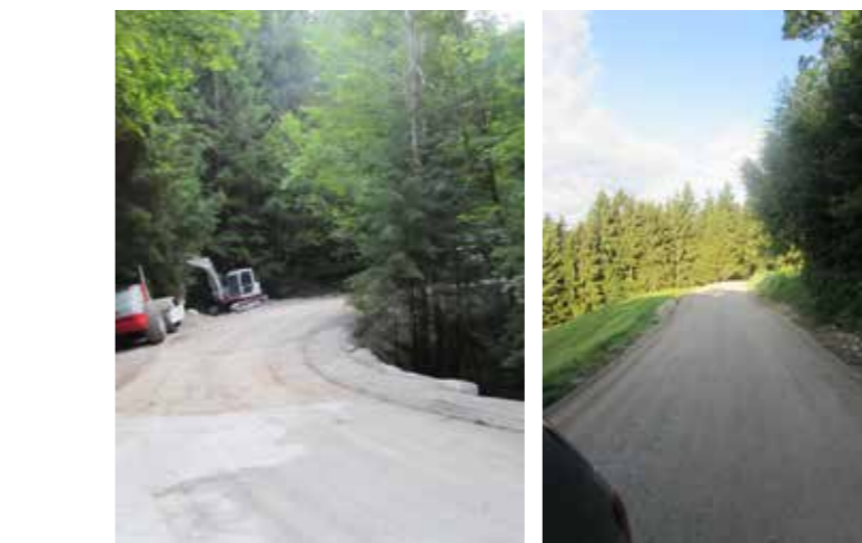
Rekonstrukcija ceste na Paki V naselju Paka se je izvedla rekonstrukcija na lokalni cesti LC 460040 Slatinškov vrh – Hudinja –Vodnik (proti Rakovcu) v dolžini 1000 m in širine asfalta 4 m.
