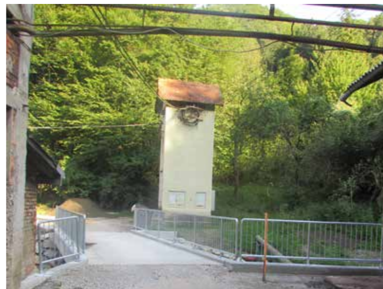
Most na Fužinah Dotrajan most je na javni poti JP 960310 Fužine – Levovnik, ki prečka potok Hudinja, smo nadomestili z novim armiranobetonskim mostom, ki bo prenesel tudi prevoz lesa iz bližnjih gozdov.
