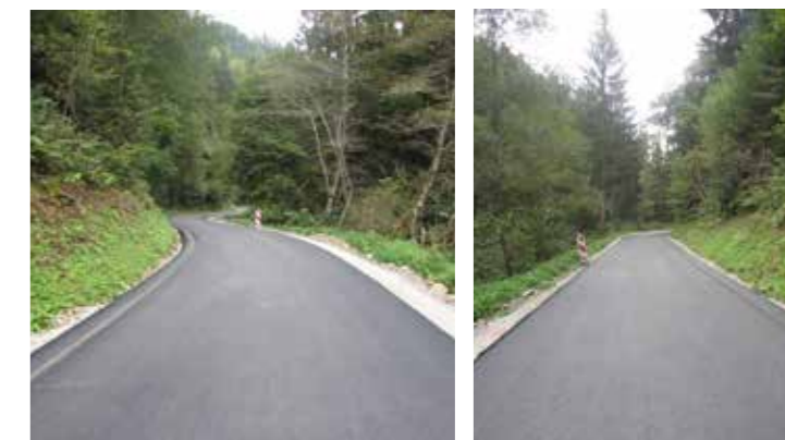
Obnova ceste v Ledinskem grabnu Cestišče na lokalni cesti LC 460040 Vitanje – Kavčič smo obnovili v dolžini 300 m zaradi dotrajanosti asfalta.
