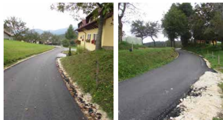
Rekonstrukcija ceste v Ljubnici S pomočjo krajanov, ki so pripravili podlago za asfalt v naselju Ljubnica, smo izvedli del rekonstrukcije javne poti JP 960090 Kiklič – Rebernik v dolžini 500 m in širine asfalta 3,5 m.
